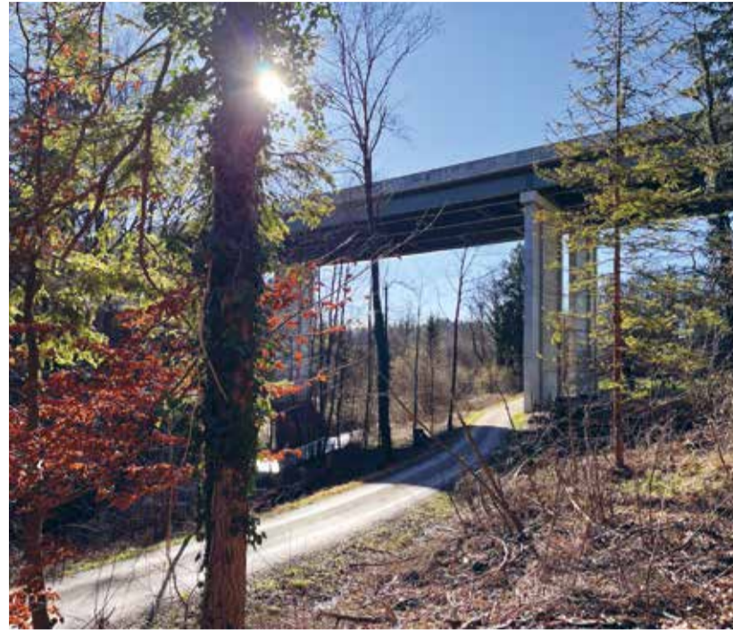
Tat- oder Unfallort? Die Lützelburgbrücke bei Aawangen.
