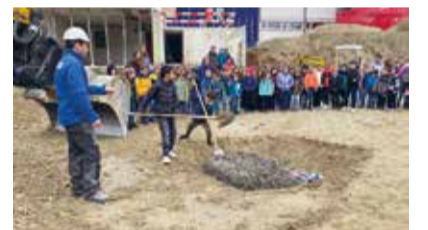
Die Schüler betonieren die Grundsteine ein.
