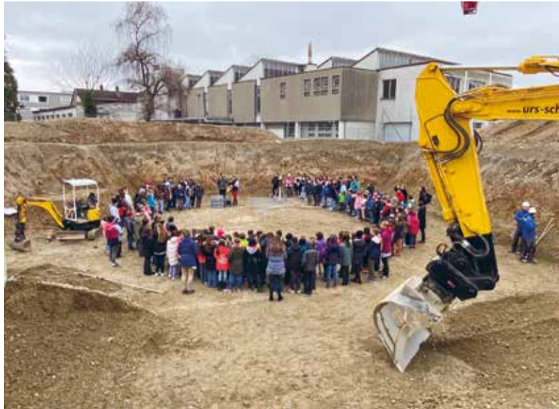
Der Schülerkreis in der Baugrube.
