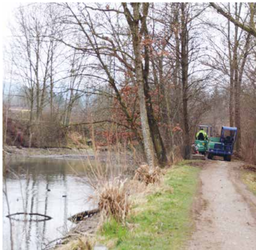
Die Reparaturarbeiten am Damm haben in der vergangenen Woche stattgefunden.
