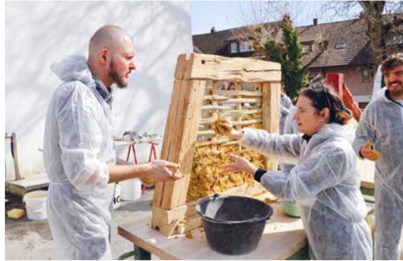
Hand anlegen für den Aufbau einer Lehmwand.
