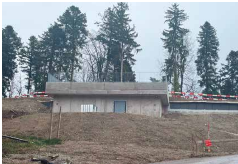
Das kurz vor der Fertigstellung stehende Reservoir Fohrenberg.
