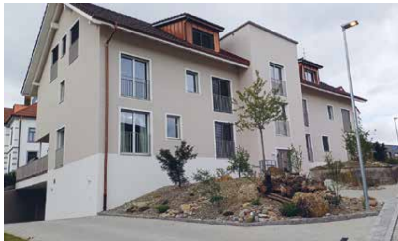
Das gefällige Gebäude «W-16» an der Wiesentalstrasse 16.
