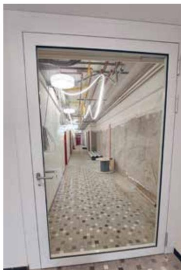
Die Arbeiten im Korridor Untergeschoss: Brandabschottungen, ein zusätzlicher Brandabschnitt mit Spezialtüre, neue Vereinsschränke und Deckeninstallationen.
