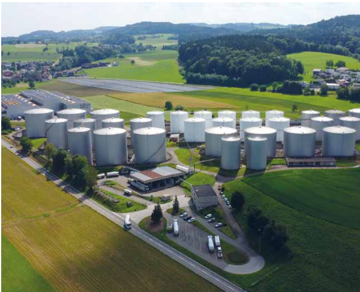
Das Lager in Tobel-Tägerschen umfasst 31 verschiedene Tanktürme. Mit Güterwaggons wird der Kraftstoff angeliefert und auf der Strasse weitertransportiert.
