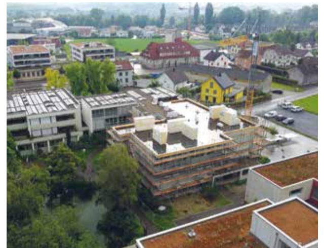
Die Aufstockung des Ostflügels wurde in weniger als vier Monaten realisiert.
