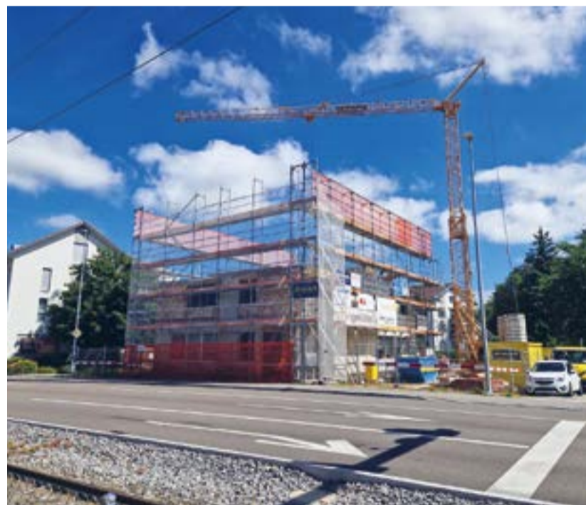
Wie ein Blick vor Ort zeigt, konzentrieren sich die Bauarbeiten auf das zweite Obergeschoss.
