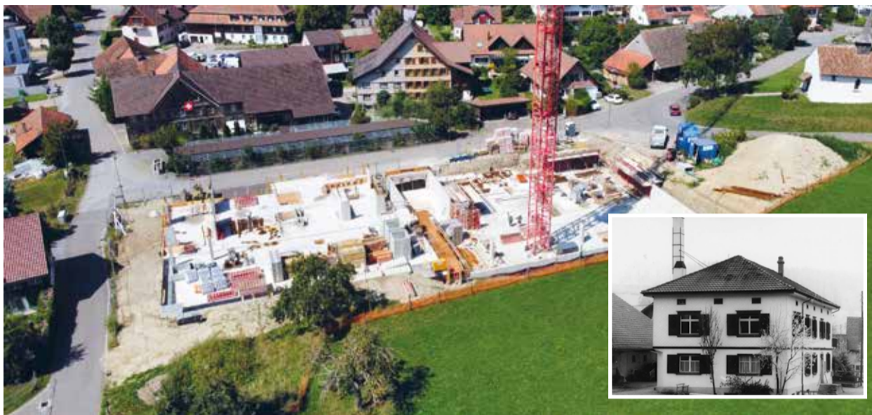
Auch im Hinterthurgau ist der Heimatschutz immer mal wieder im Einsatz. So wie vor einigen Jahren als es in der Gemeinde Braunau um den Abriss der alten «Chäsi» ging. Wo diese einst stand, stehen nun zwei Wohnblöcke an der Dorfstrasse 8 und 10.
