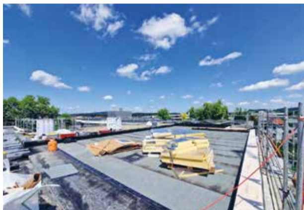
Neue Balkone mit schöner Aussicht und eine PV-Ergänzung entsteht auf dem Dach.
