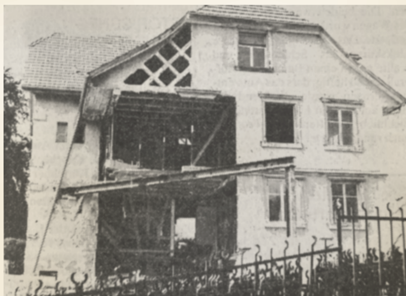
Mit Stahlträgern abgestützte Südostseite des Gebäudes.
