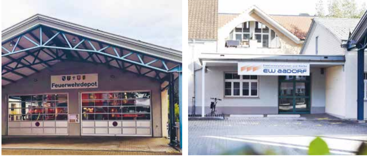
Die Feuerwehr und das EW Aadorf benötigen dringend Platz für den effizienten Betrieb und die sinnvolle Logistik.
