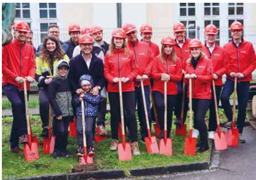
Der offizielle Startschuss für den Neubau der Raiffeisenbank Münchwilen: Zahlreiche Vertreter der Raiffeisenbank und Projektbeteiligte nahmen an der symbolischen Zeremonie teil, um den Beginn des Bauprojekts zu feiern.
