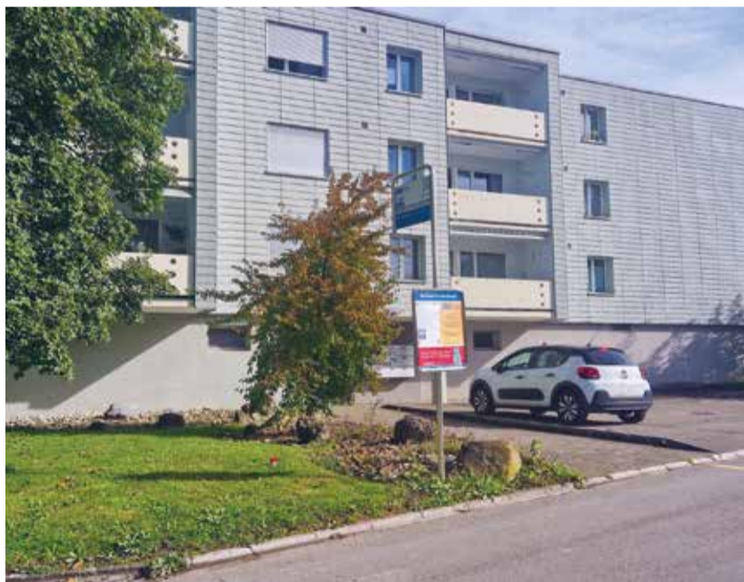
Die Bushaltestelle Eschlikonerstrasse in Münchwilen kurz vor dem Umbau.
