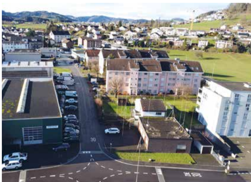
Visualisierung des Neubaus an der Oberhofenstrasse 15 in Sirnach: Geplant sind ebenfalls Wohnungen in den oberen Etagen und Gewerbeflächen im Erdgeschoss.
