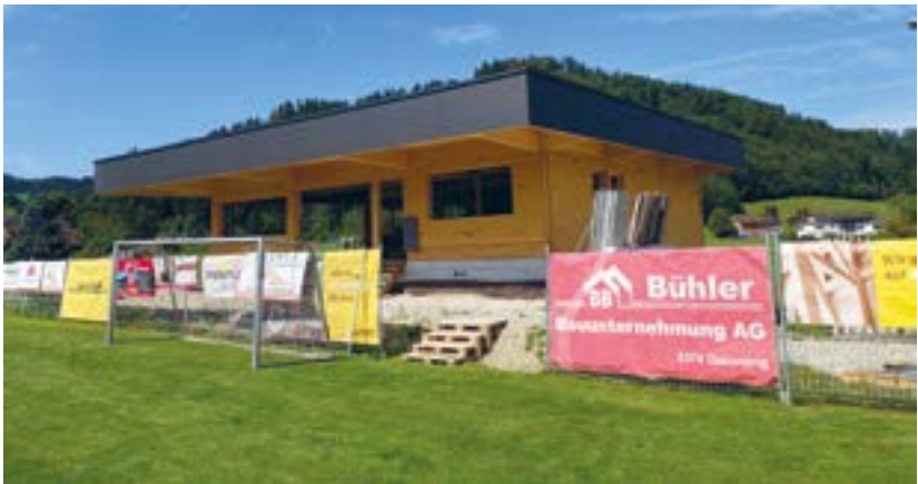
Das neue Clubhaus nimmt langsam aber sicher Form an.
