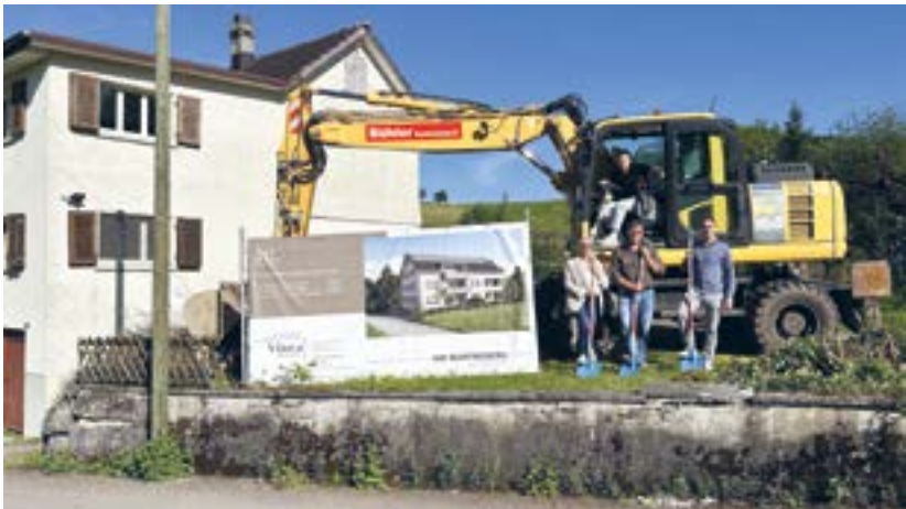
Glückliche Gesichter am Spatenstich Mitte Mai in Oberwangen.
