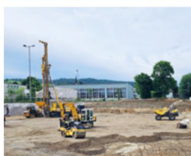
Geröll, Schotter o.Ä.) befüllt, nach oben gefahren und in das Rohr gekippt. Die Rammspitze am unteren Ende des Rohrs wird geöffnet und kontinuierlich hochgezogen. Dabei Rutscht das Stopfmaterial in das so entstandene Loch und wird
